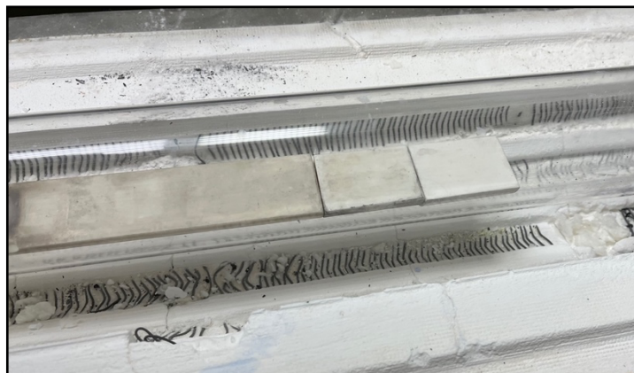
圖十五. 爐管經過一次空跑之後的樣貌
